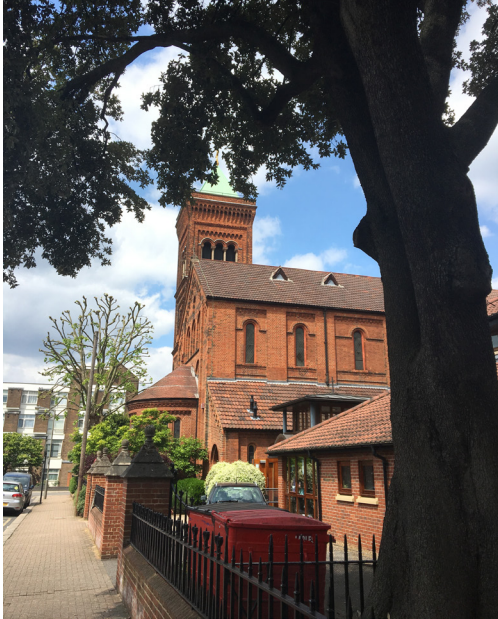
Figure 2. Bâtiment paroissial hébergeant l'antenne cellulaire
