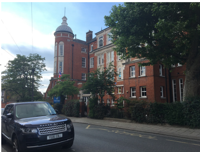
Figure 3. Bâtiment identifié comme étant la source d'interférence
